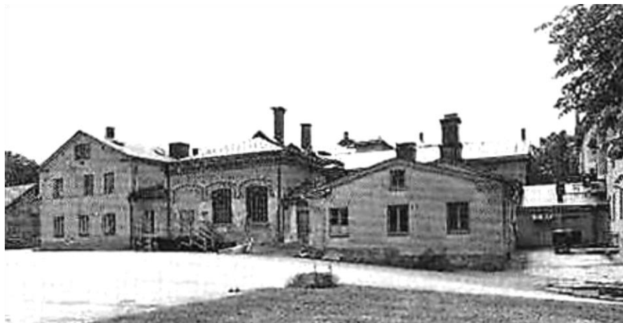
Bild 9 41) Hus 18 C – A från Grubbenstorget.
