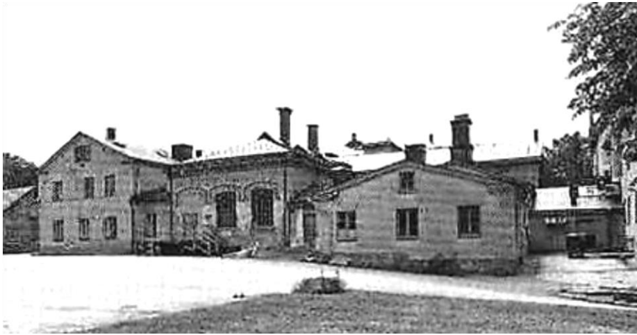
Bild 11 53) Hus 18 C – A från Grubbenstorget 1998.
